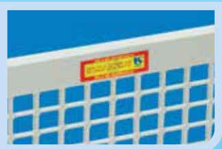
Selo de Segurança fixado na tampa montada na Caixa com parafuso montado. Somente a SABESP poderá retirá-lo.
