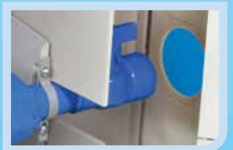
Compartimento do usuário com o registro esfera do dispositivo simples NTS-195 SABESP
